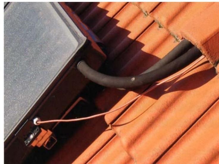
Незащищен и не закреплен датчик кабеля
