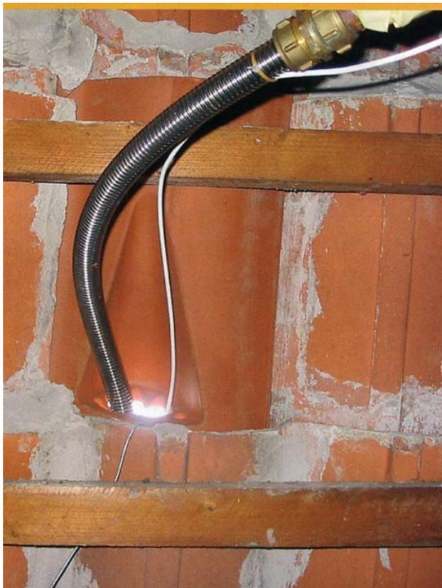
Подающая линия не изолирована, без изоляции на обрешетке крыши = опасность пожара
