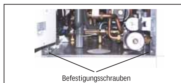
Bild: Befestigungsschrauben vorne
