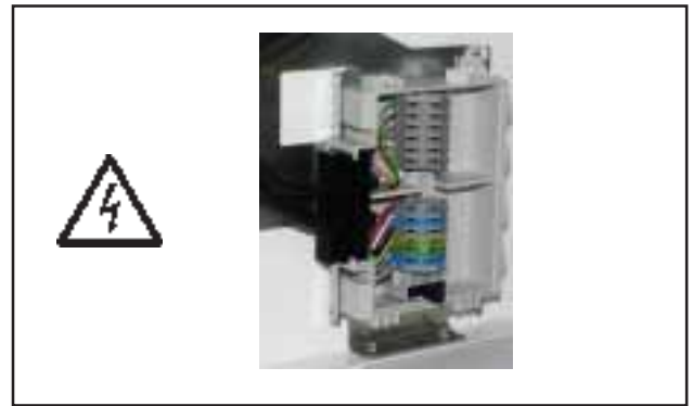
Bild: Klemmkasten: Gefahr durch elektrische Spannung
