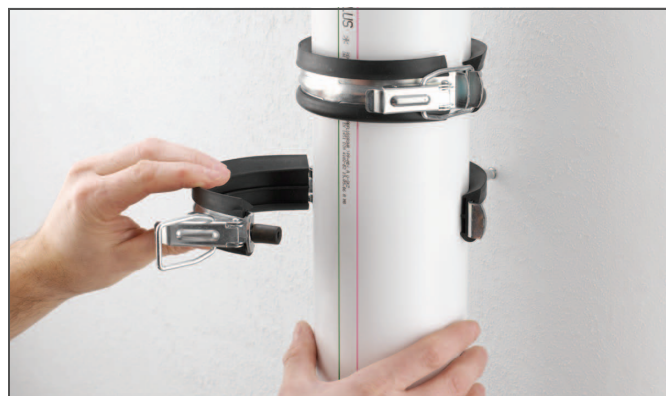
Рис. 7-2 Закрытие опорного хомута
